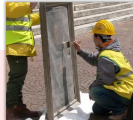
Messa in sicurezza - Opere di preconsolidamento
